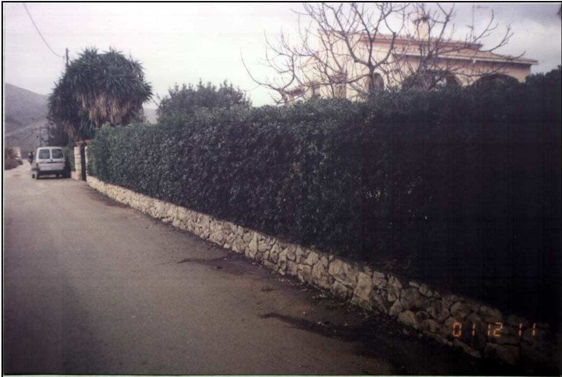
FOTO 10: VALLADO A DEMOLER Y REPONER, PK 0+200, MARGEN DERECHA.
