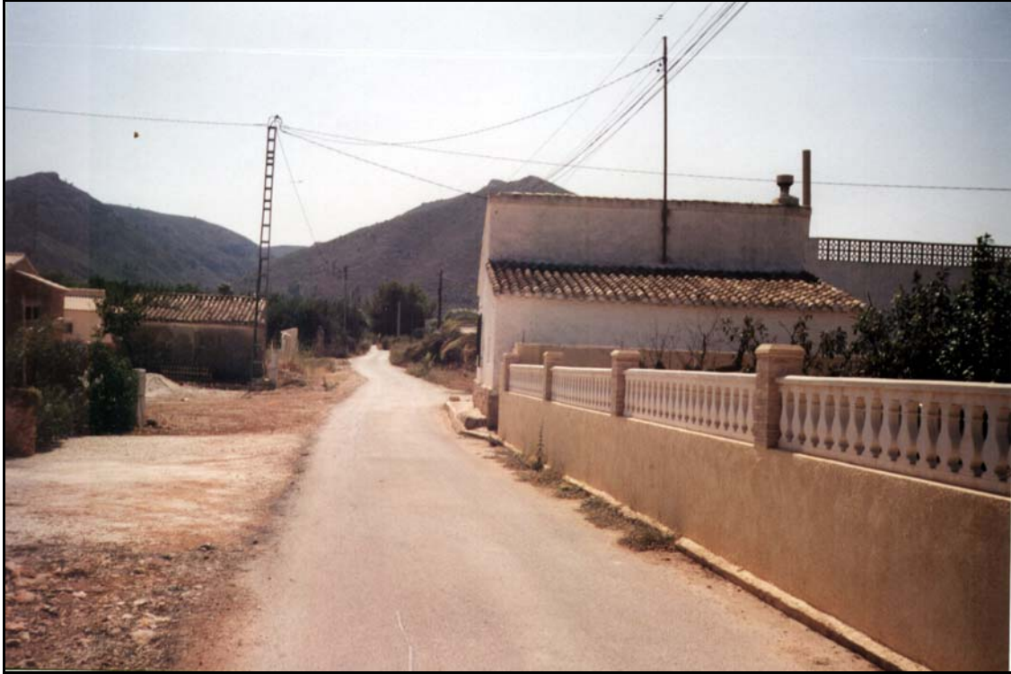
FOTO 16: FACHADA EXISTENTE PK 0+400. MARGEN IZQUIERDA. VISTA CAMINO HACIA ATRÁS.
