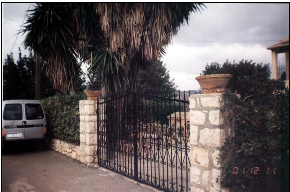
FOTO 11: VALLADO A DEMOLER Y REPONER, PK 0+200, MARGEN DERECHA. PUERTA DE ACCESO A TRANSLADAR.
