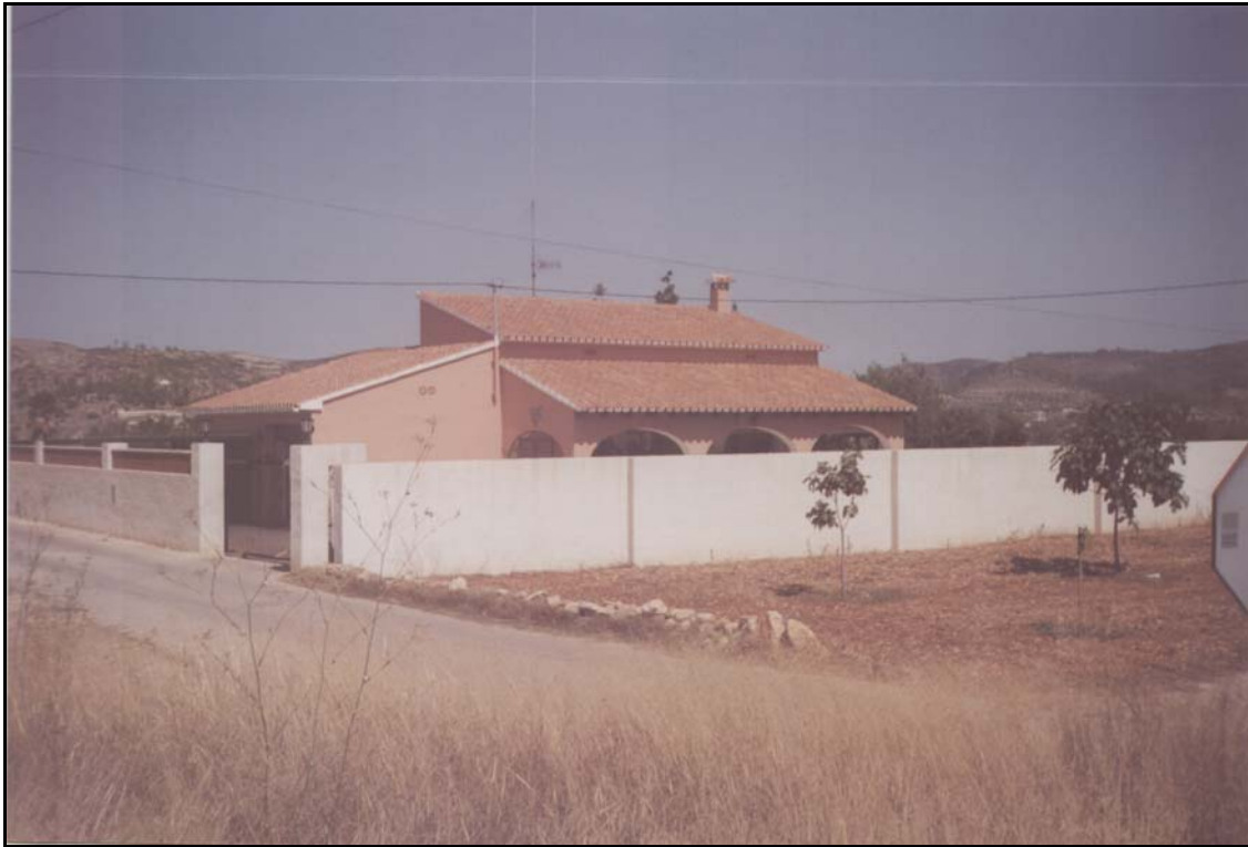
FOTO 6: VALLADO A DEMOLER Y REPONER, UBICADO ENTRE LOS PK 0+000 Y 0+068. MARGEN DERECHA.
