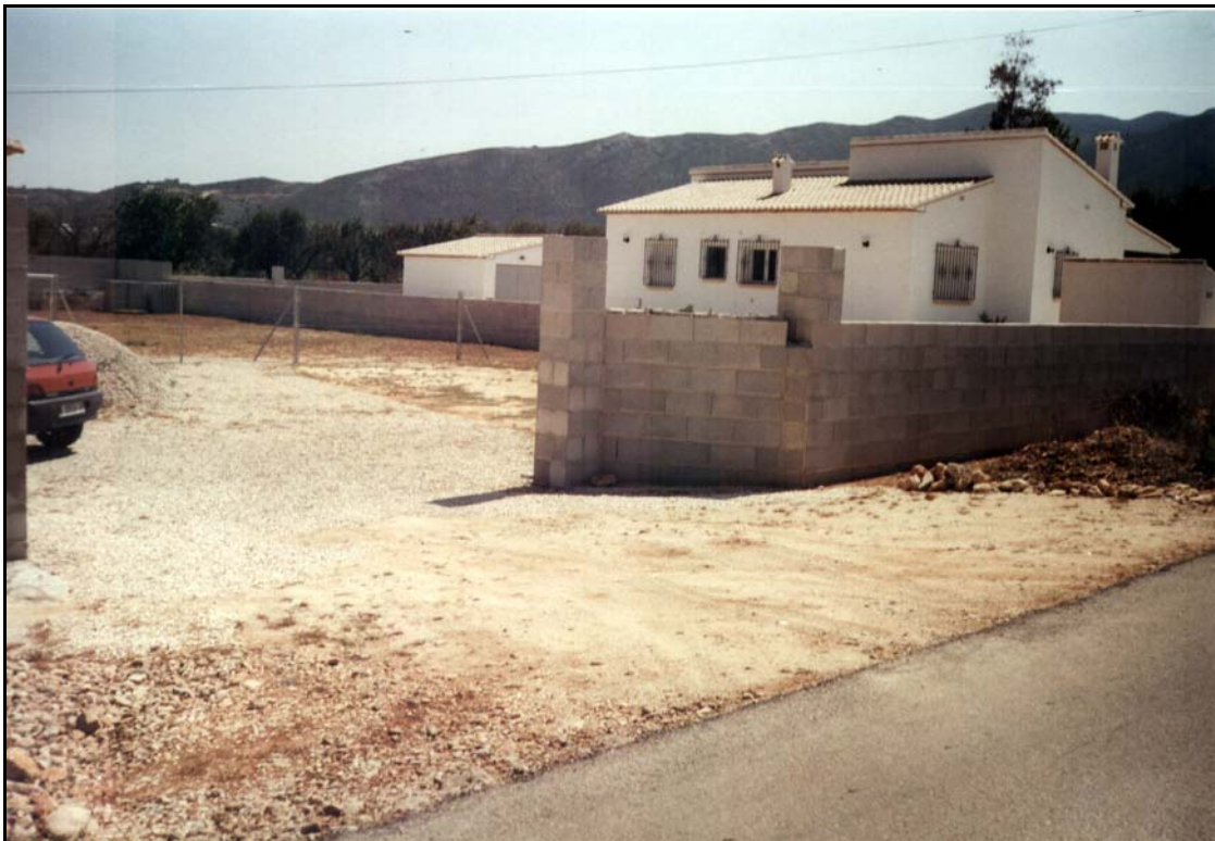
FOTO 19: VALLADO EXISTENTE. LADO DERECHO. PK 0+540.
