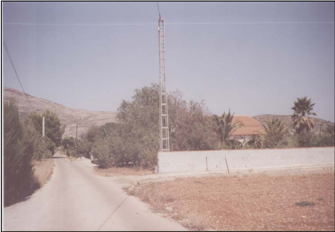
FOTO 8: VISTA LONGITUDINAL DEL CAMÍ CUTES BAIXES EN EL PK 0+080.
