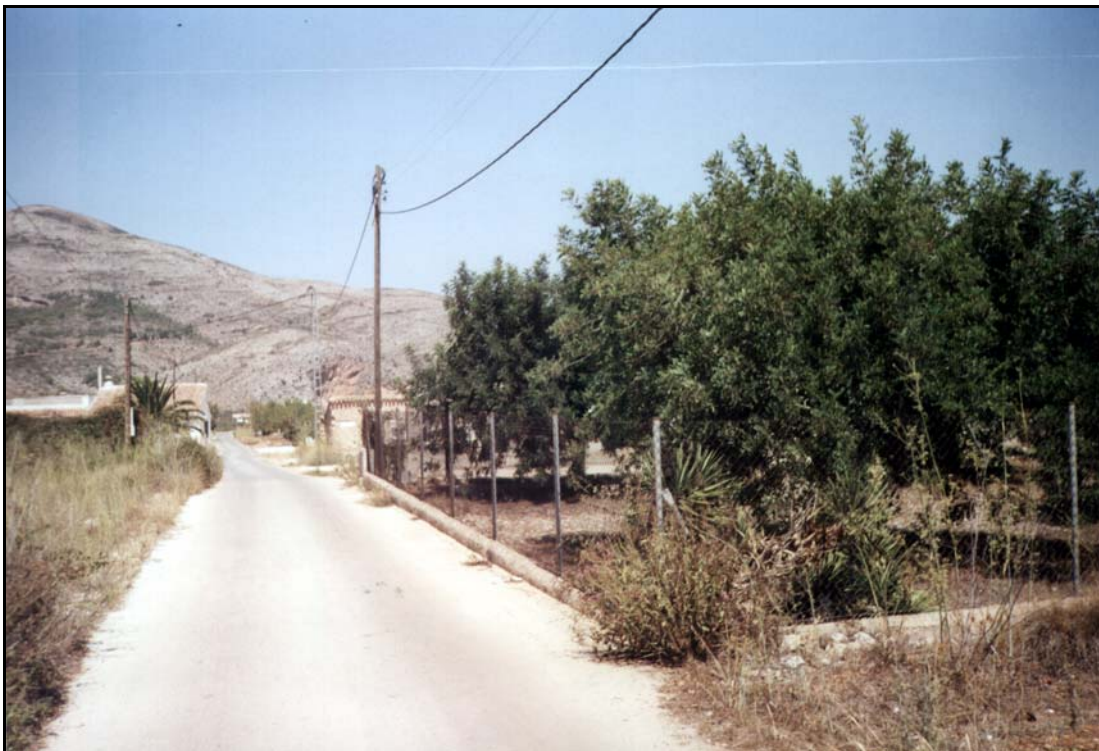
FOTO 14: VALLADO Y POSTE A REPONER. VISTA CAMINO HACIA DELANTE. PK 0+270.
