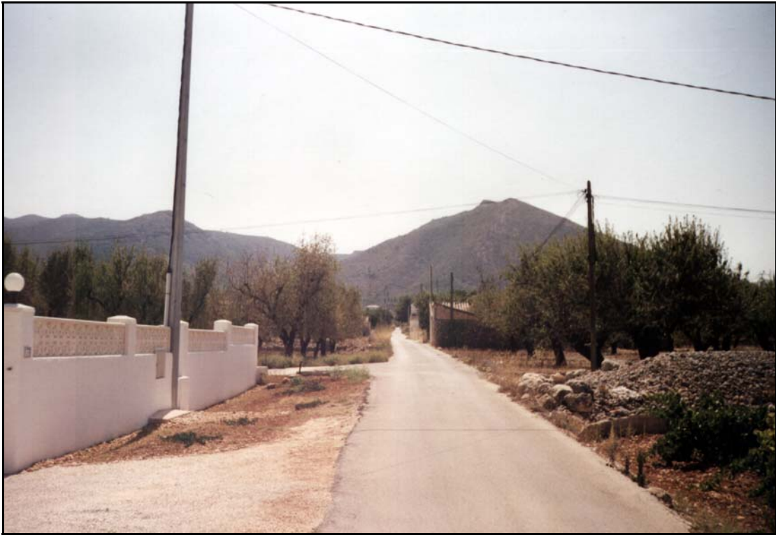
FOTO 18: VISTA CAMINO HACIA ATRÁS. PK 0+520.
