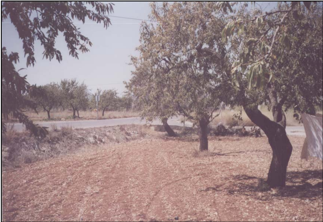
FOTO 4: ENTRONQUE CON LA CARRETERA CV-750. INICIO DE LAS OBRAS.
