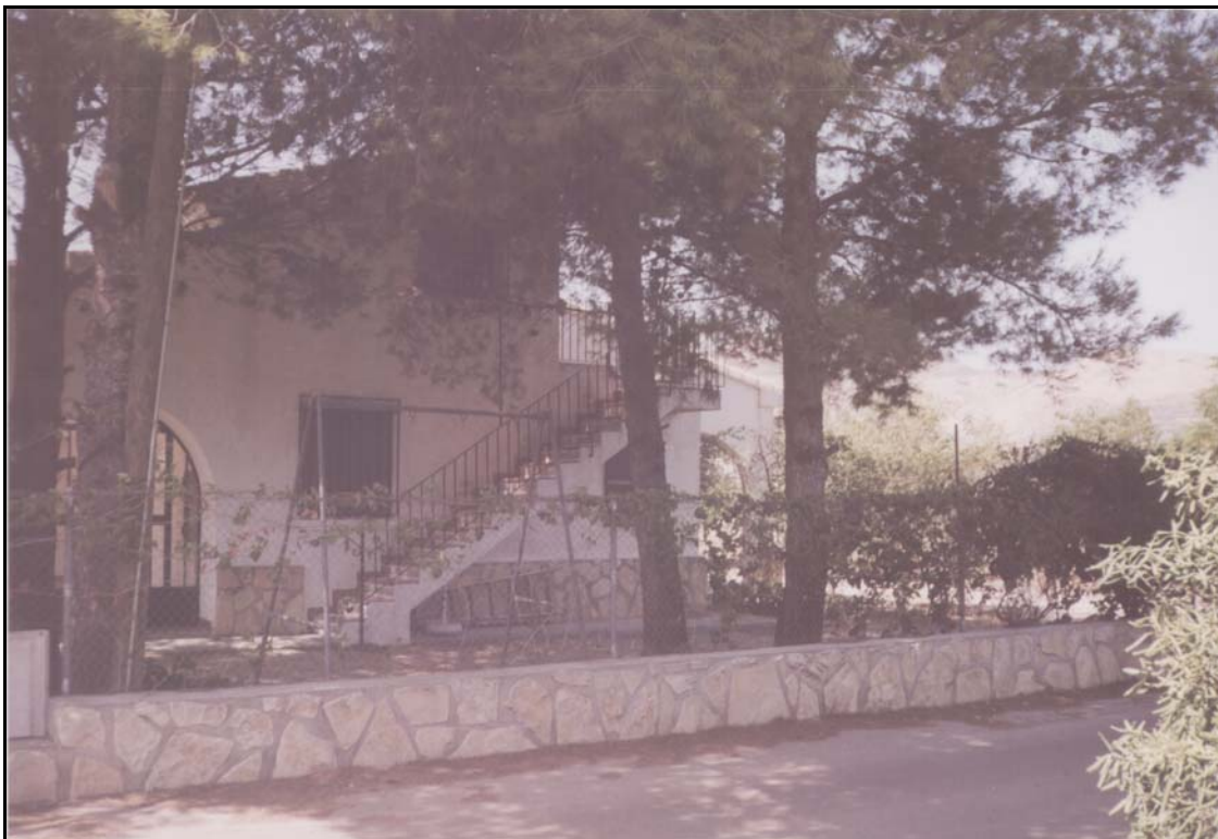
FOTO 9: VALLADO A RESPETAR, UBICADO EN EL PK 0+200. MARGEN IZQUIERDA.
