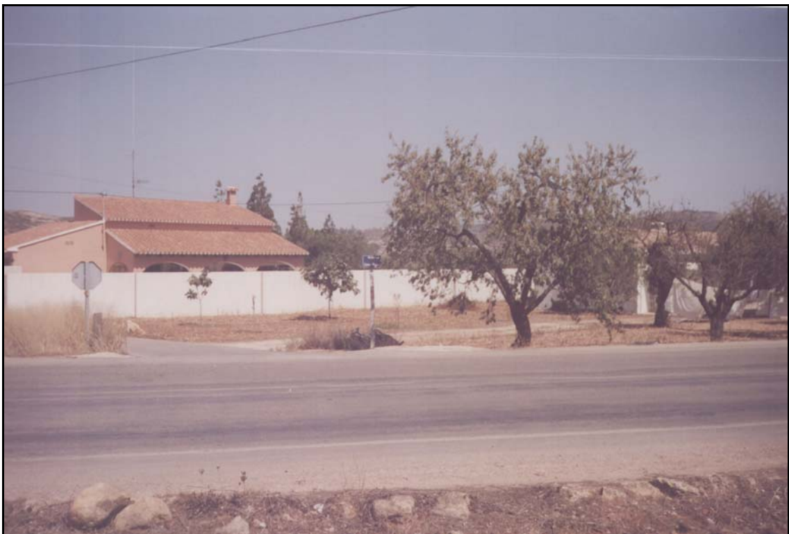
FOTO 3: ENTRONQUE CON LA CARRETERA CV-750. INICIO DE LAS OBRAS.
