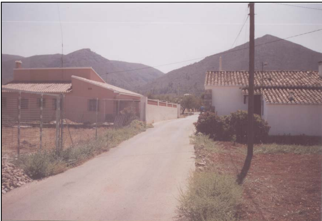
FOTO 7: VALLADO A DEMOLER Y REPONER, UBICADO ENTRE LOS PK 0+000 Y 0+068. MARGEN DERECHA.
