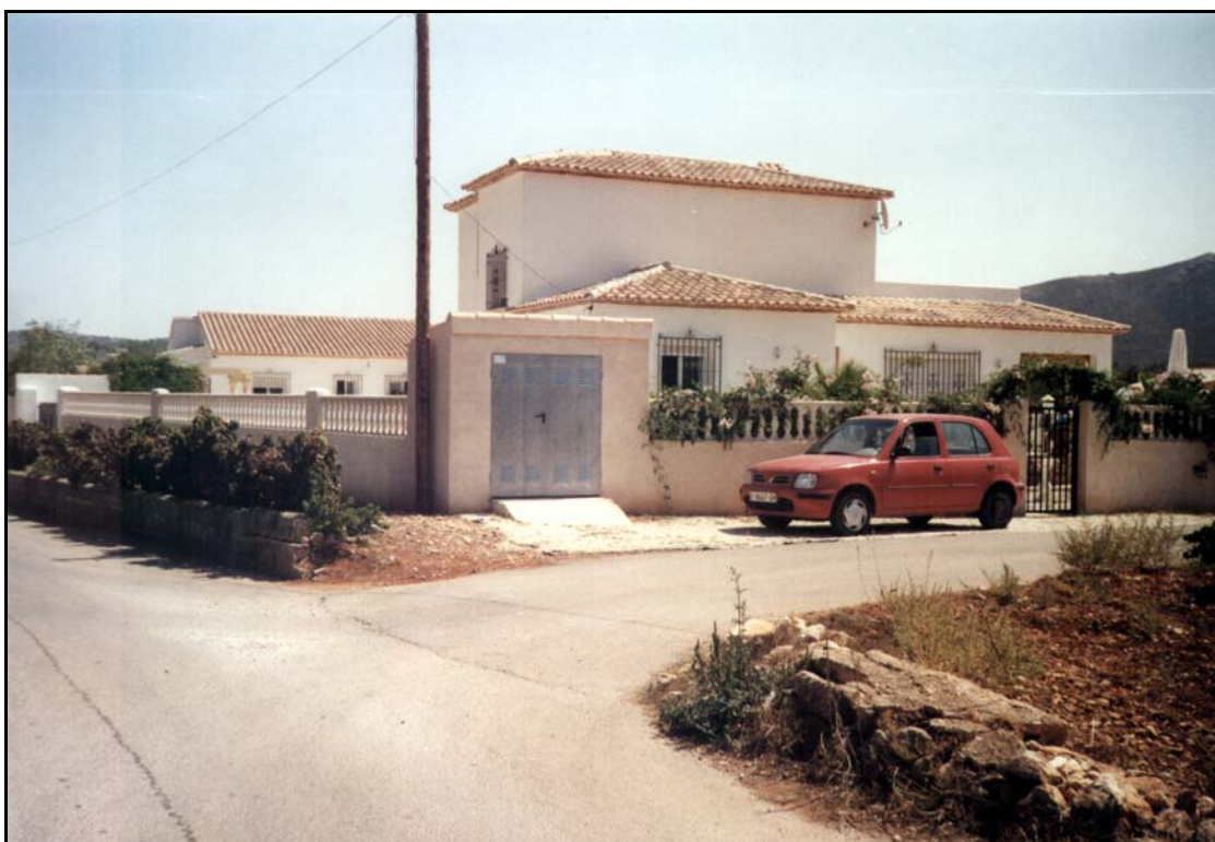
FOTO 21: CHAFLÁN DEL EJE Nº1 CON EL EJE Nº3.
