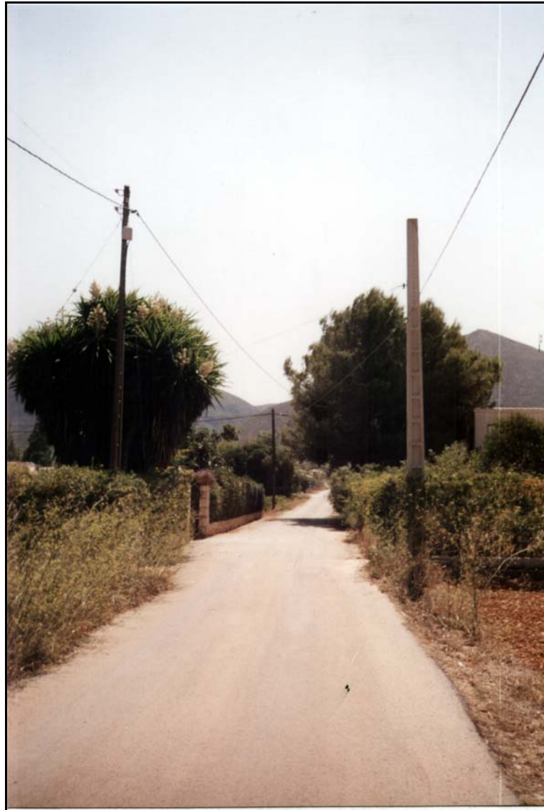
FOTO 12: VISTA DEL CAMÍ CUTES BAIXES HACIA ATRÁS. PK 0+240.
